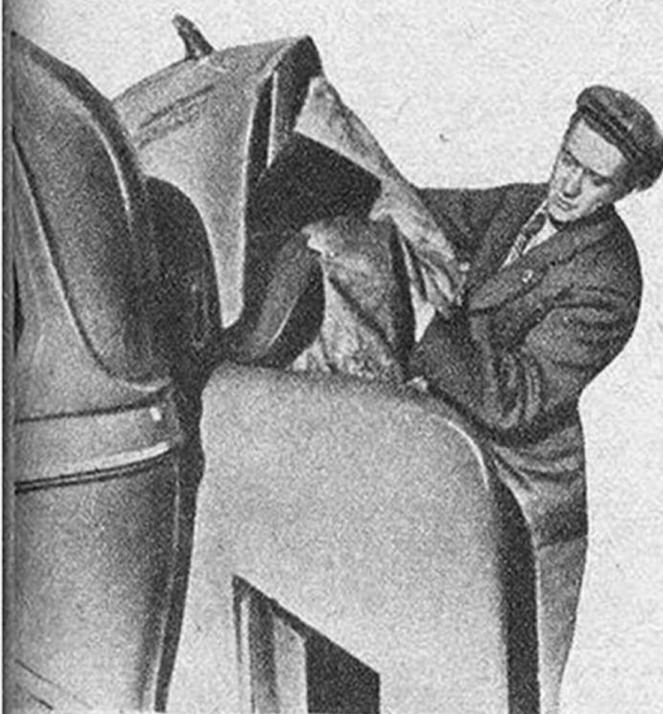
Загрузка дров в газогенератор.
