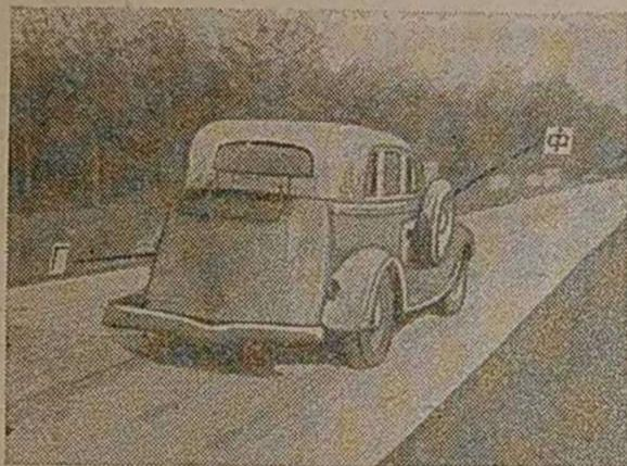
Рис. 1. Общий вид газогенераторной легковой автомашины М-1
