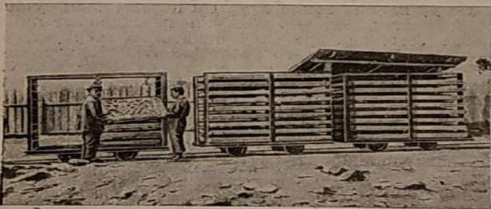
Рис. 7. Загрузка вагонок сушильными ситами, наполненными щепой.
